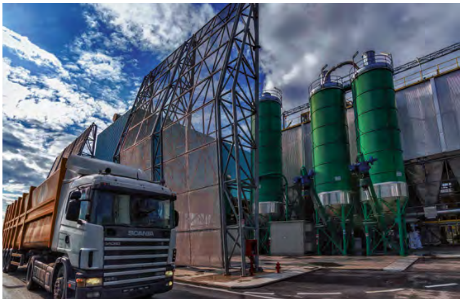
San Vittore nel Lazio (Frosinone province), view of Waste-to-Energy plant
