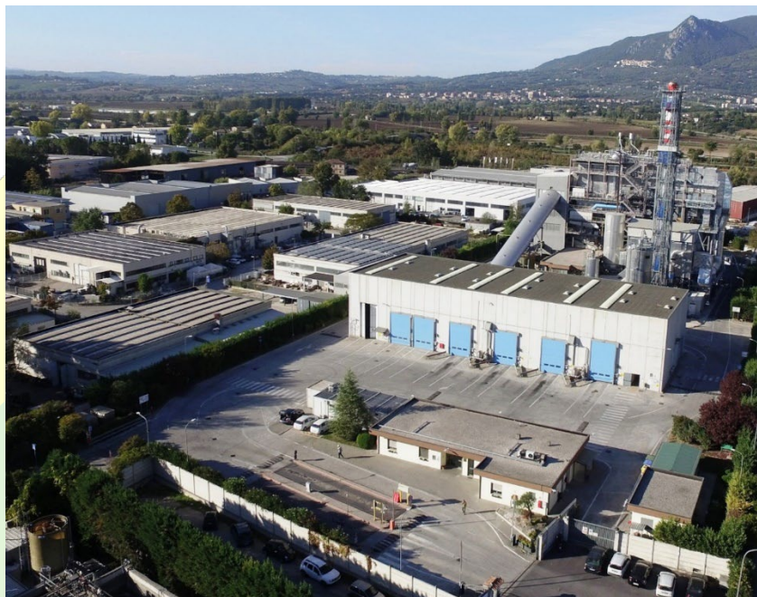
Figura 11 - Veduta dell'impianto Acea Ambiente nell'ambito del contesto industriale di Maratta Bassa
