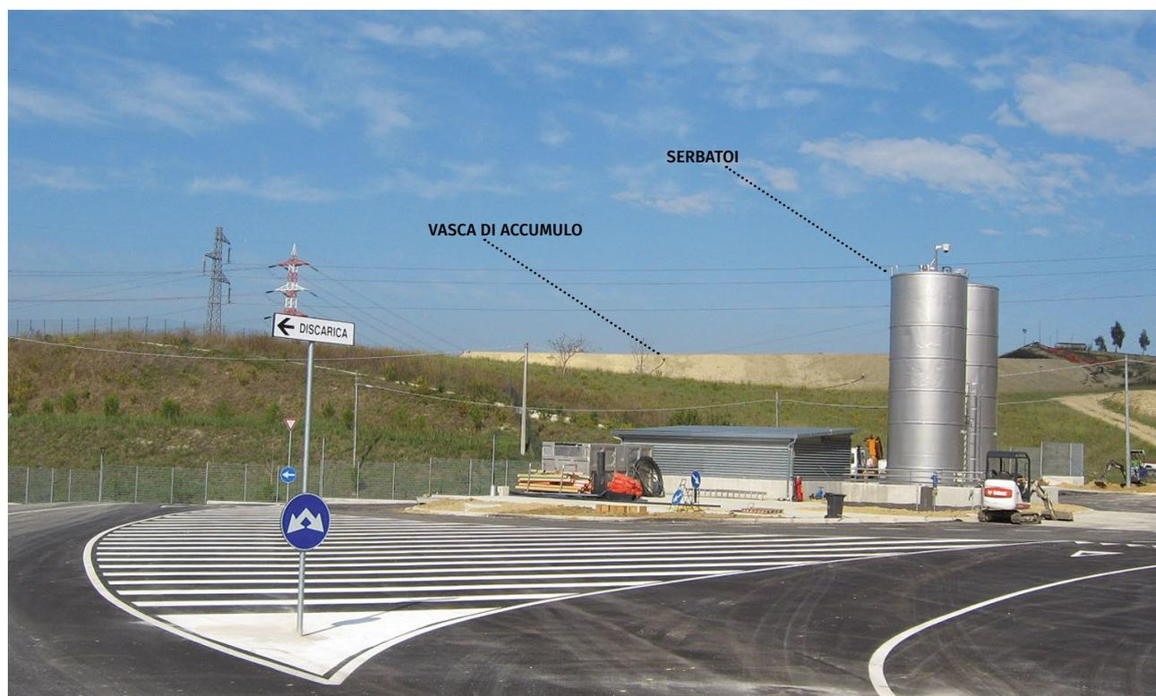
Figura 20 - Raccolta acque di processo Fonte: repertorio Deco S.p.A
