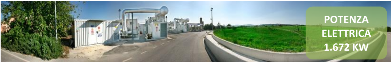
Figura 7 – Vista dell'impianto di recupero energetico
