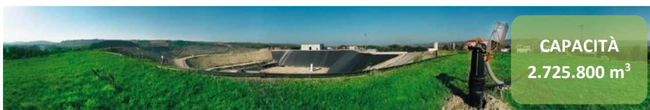
Figura 4 – Vista della discarica di Cerratina
